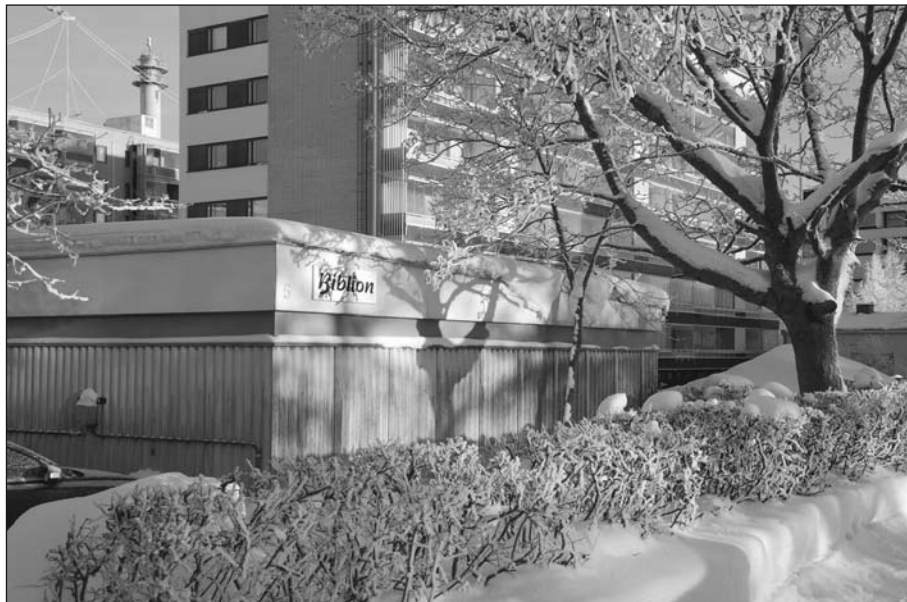
Biblion-fastigheten i vinterskrud. En eventuell reservutgång skulle komma precis invid väggen på bilden, som utgör den övre delen av kyrksalens fondvägg. Fasaden är inte den vackraste och väntar på åtgärder.
